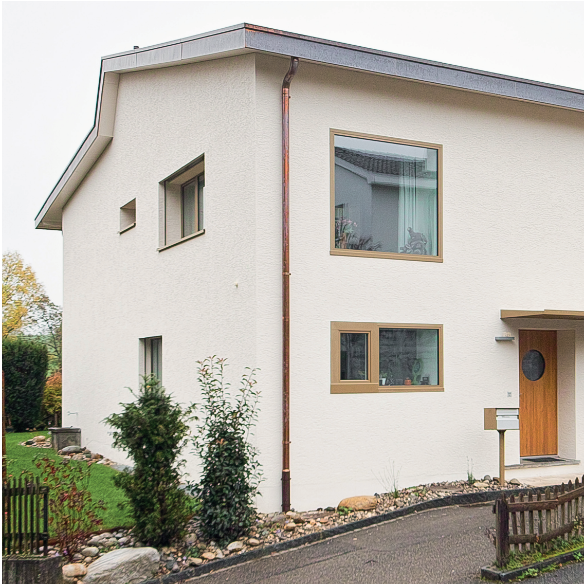
Energetische Sanierung, EFH Allschwil, 2019 [Abb. 9]
