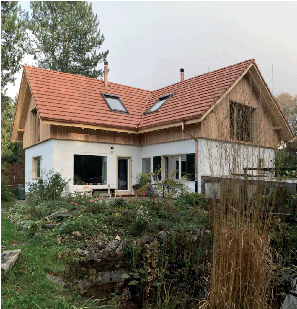
Erneuerung Dachstock, EFH zu Clusterwohnung Hochwald, 2014 [Abb. 11]
