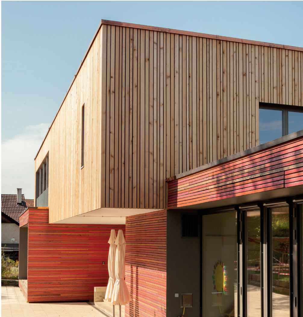
Erweiterung Aufstockung, Kindergarten Itingen, 2017 [Abb. 10]
