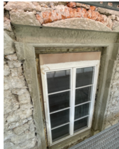
Façade pendant les travaux
