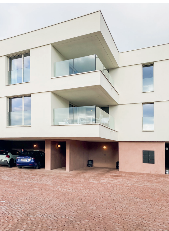
Mit Sol-Silikatfarbe beschichtete Hausfassade in Corminboeuf FR. (Bild: Keimfarben)
