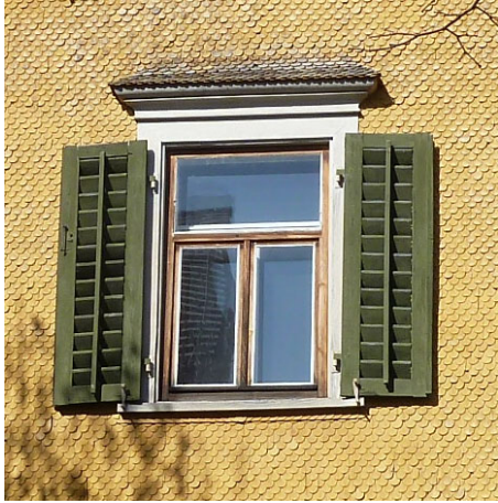
Abb 08 Fenster mit Schindelschirm
