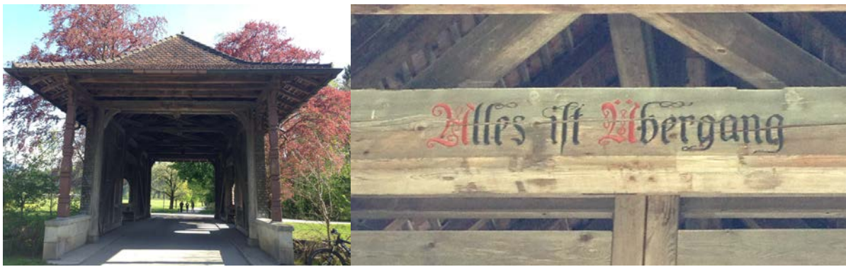
Abb. 19 und 20 Aabachbrücke Schmerikon (SG) Baujahr 1917
