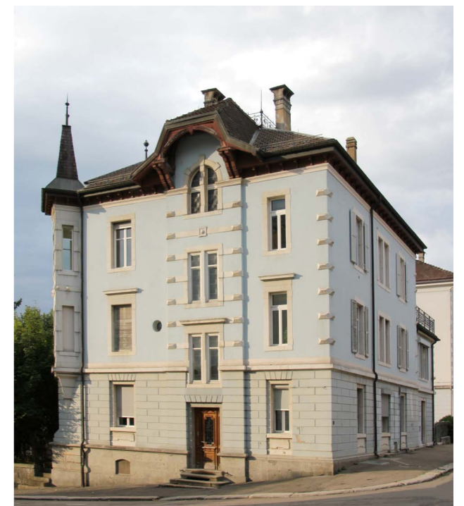
Rénovation durable d'un bâtiment historique à la Chaux-de-Fonds
