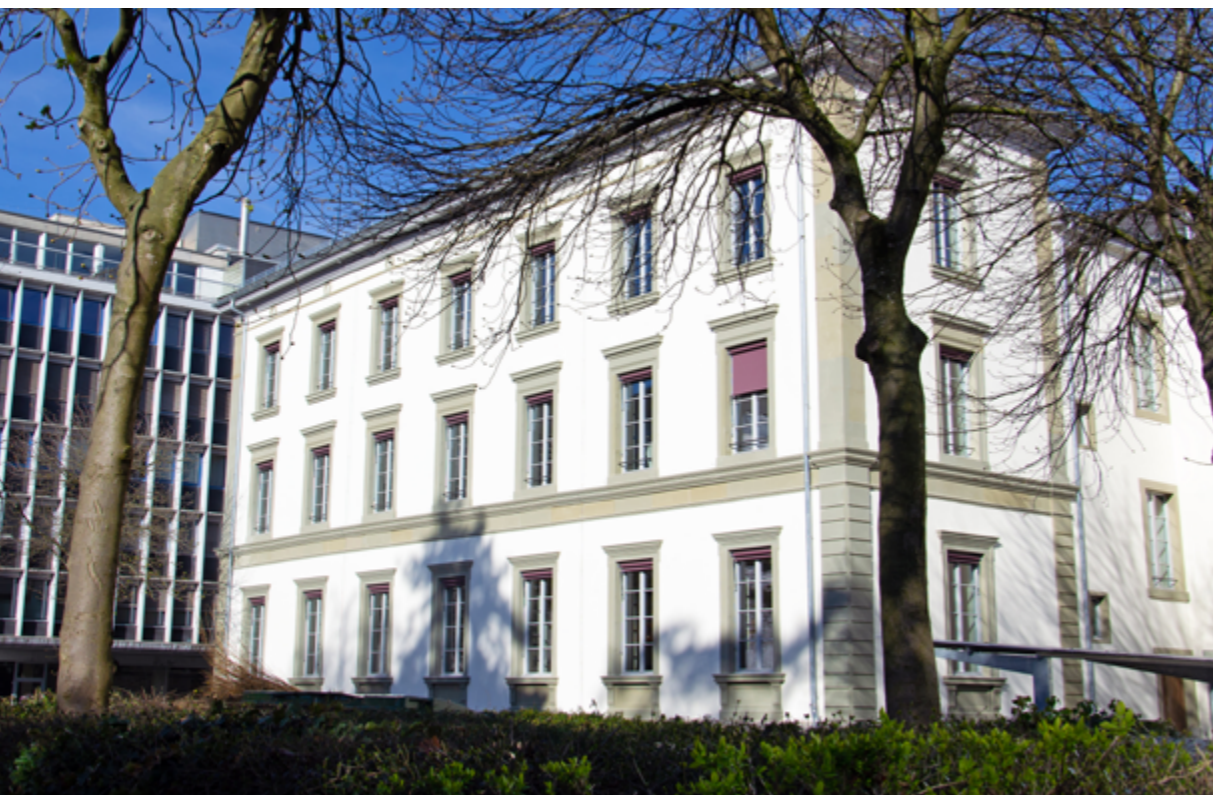
sanu-Gebäude nach der Renovation
