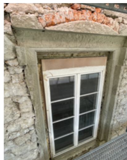
Fassade während des Umbaus
